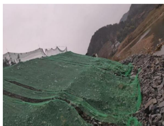
临时道路边坡
