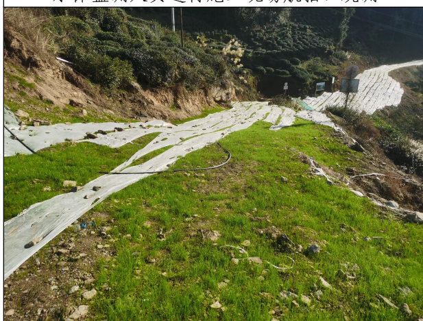
对裸露地表进行植草并覆盖保温膜
