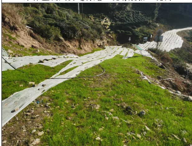
对裸露地表进行植草并覆盖保温膜
