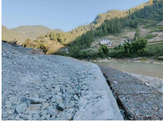
枢纽 2#渣场钢筋石笼护坡
