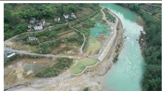
枢纽 2#渣场已完成渣土堆存区苫盖、拦挡及排水措施
