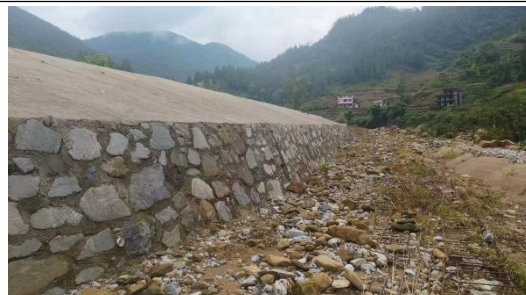
枢纽 2#渣场已完成渣土堆存区苫盖、拦挡及排水措施
